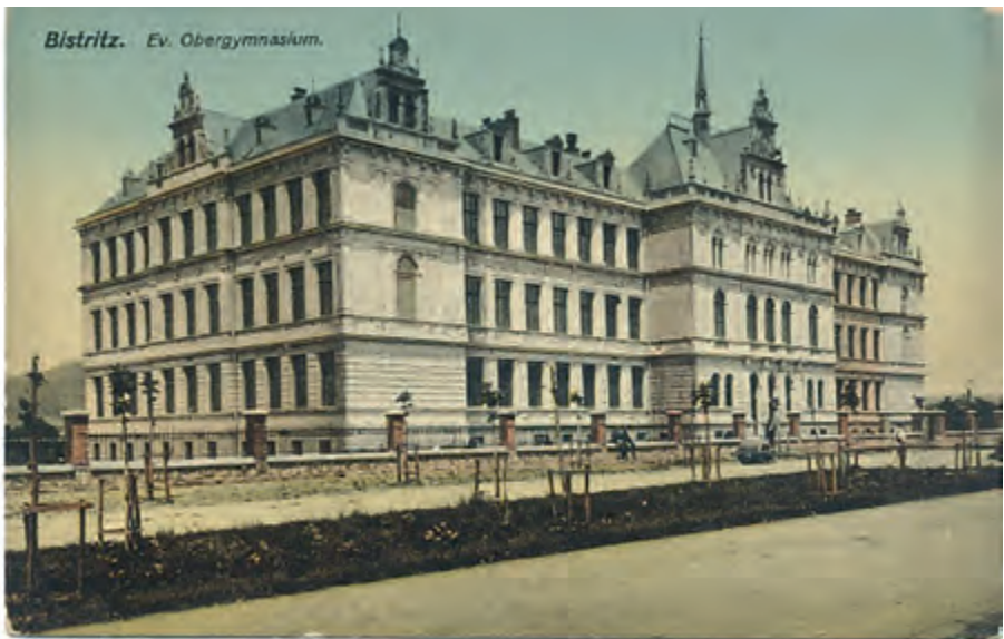
Das neue Gymnasialgebäude um 1910 auf einer historischen Ansichtskarte
